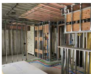
通電前の屋内作業に
